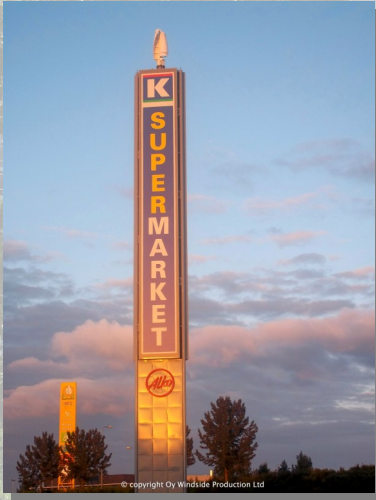
K-supermarket Jalasjärvi: WS-2B mainospylonin valaistuksen lisä-energianlähteenä.
