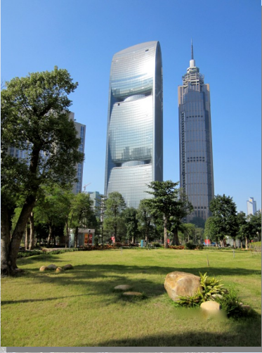
Pearl River Tower, Guangzhou, Kiina: WS-10 –tuuliturbiinit osana rakennuksen energiajärjestelmää.
